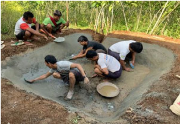
事業対象者による農業用のため池作成風景
